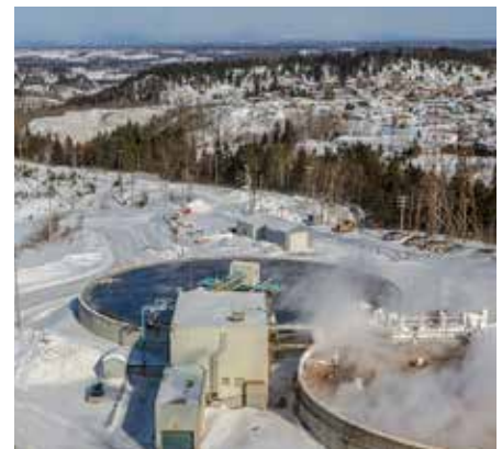
Système de traitement des effluents, Kénogami
